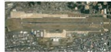
国土交通省 博多港湾・空港整備事務所資料より
