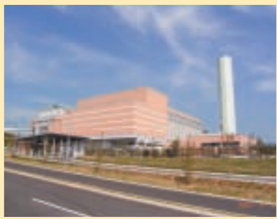
▲資源・エネルギーの有効利用を推進する良好な社会環境 ((株)福岡グリーンエナジー東部工場)
