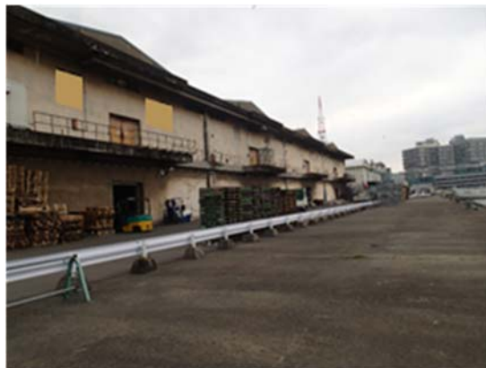
写真 3-1 ガードレールの設置状況
