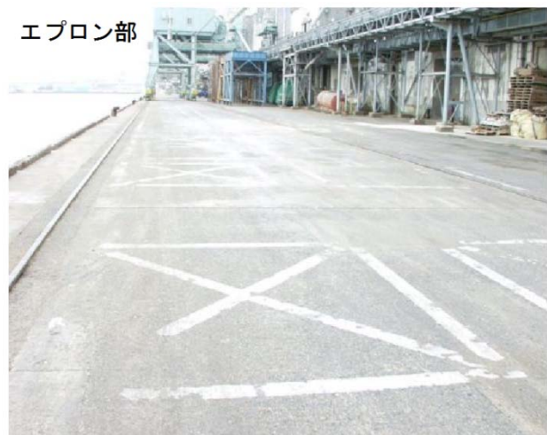
岸壁の利用制限（白枠×マーク） ※集中荷重がかけられない箇所
