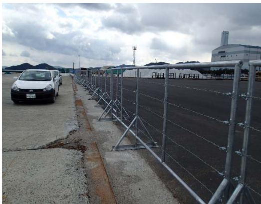
写真 2-1 バリケードの設置状況
