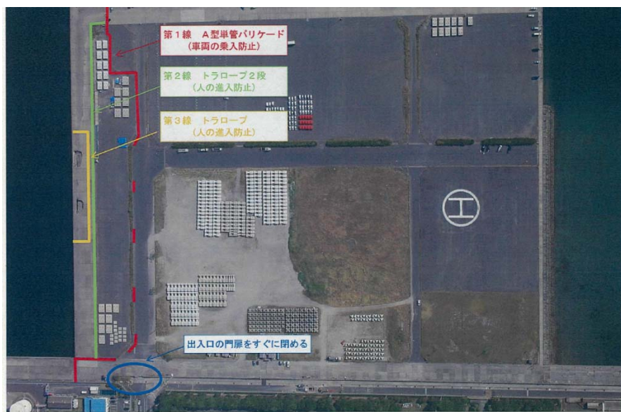
写真 4-2 バリケードの設置状況
