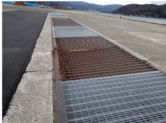
写真 2-2 渡版の応急措置の状況
