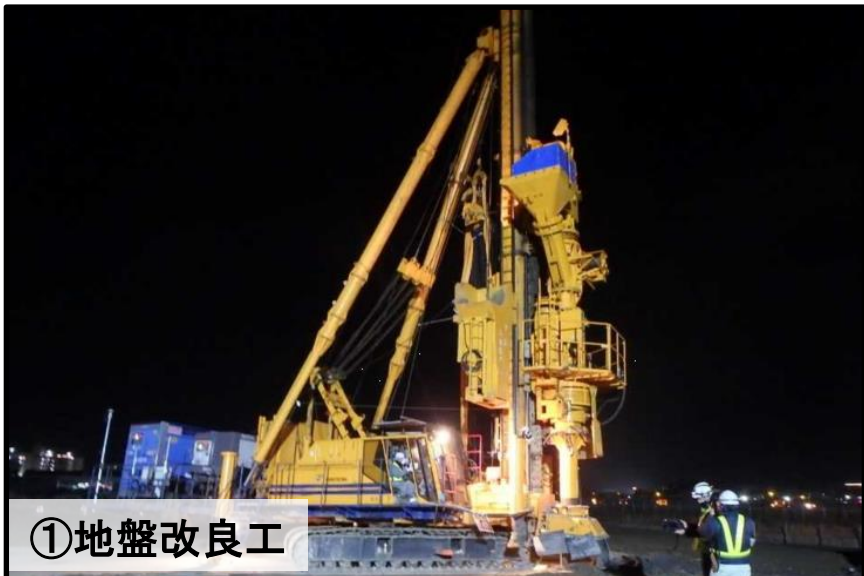
●液状化対策のための地盤改良を行います。
