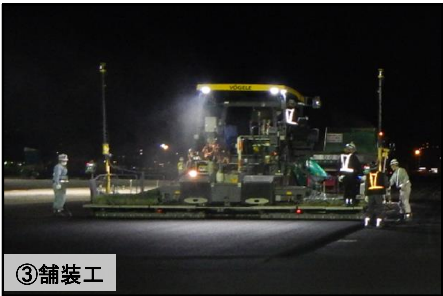
●飛行機を安全に走行させるため、アスファルト等で舗装を行います。
