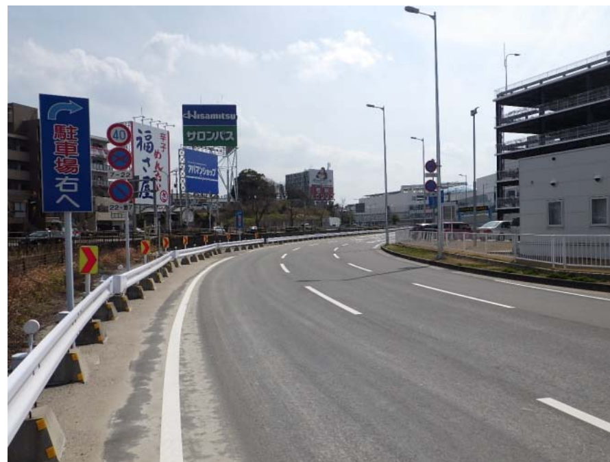
③立体駐車場出口付近
