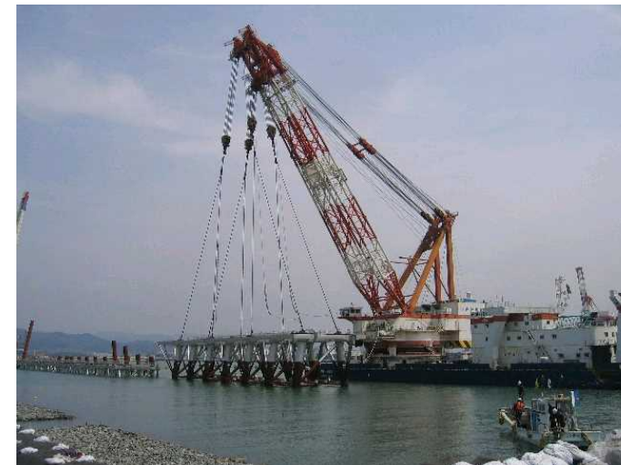
ジャケット据付(海上)
