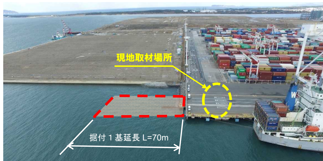
ジャケット据付位置
