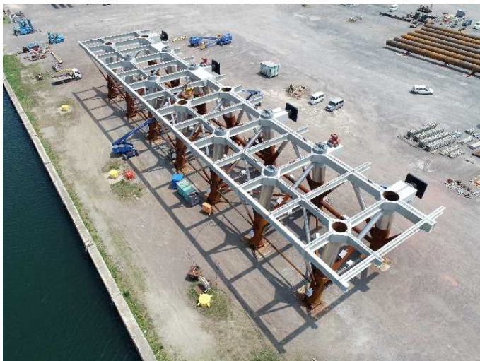
ジャケット製作(工場)
