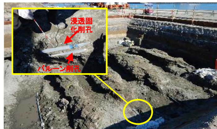
追加削孔実験の様子
