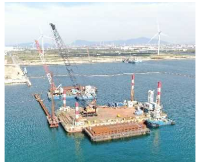
基地港湾整備の様子
