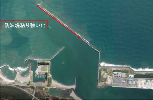
宮崎港防波堤
