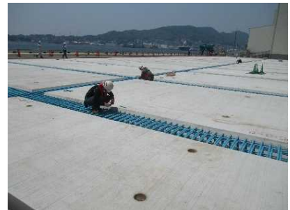
床版設置の様子
