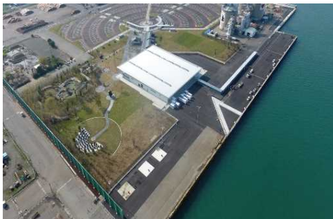
令和2年3月に耐震強化岸壁が完成
