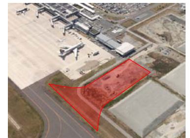
エプロン新設予定地の現況写真
