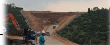
2016年春の全線開通に向け工事が進んでいる
