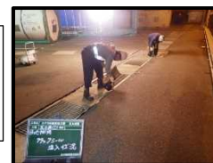
目地補修(クラクソール材注入)
