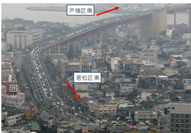
▲ 若戸大橋の様子 (高塔山から) (H23. 11・平日7時台)
