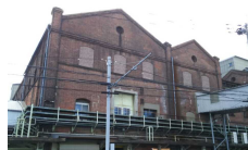
関門製糖株式会社工場棟 (旧鈴木商店大里製糖所)
