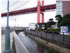
東海岸通護岸(令和2年1月撮影)
