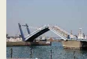
平成5年に完成した両開き非対称の跳開式可動橋です。歩行者用の跳ね橋としては国内最大で関門海峡、関門橋を見渡せる場所に架かります。
