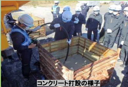
コンクリート打設の様子
