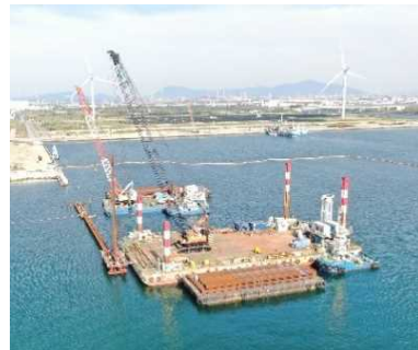
基地港湾整備の様子
