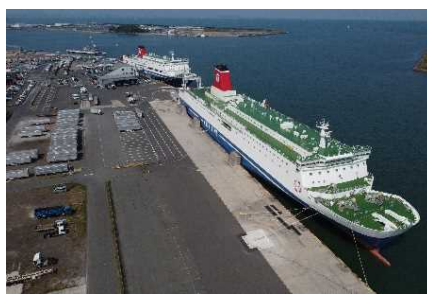
整備が完了した新門司地区
