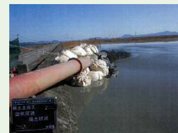
浚渫土砂の受入 (排砂管による揚土)
