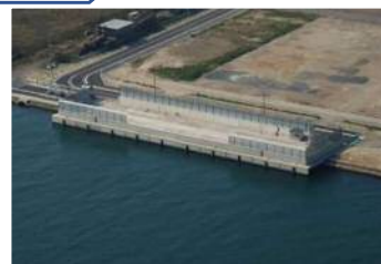
響灘リサイクルポート岸壁
