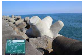
H28d テトラポッド64t型11個据付
