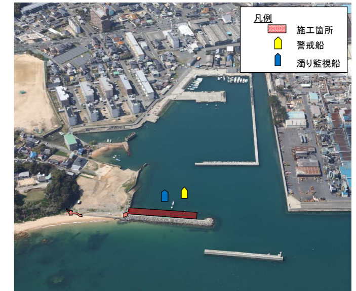
図-2 工事実施箇所(宮崎水門)
