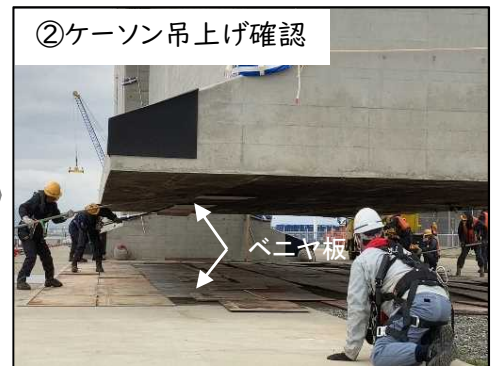
②ケーソン吊上げ確認 吊上げたケーソンの底に地面との縁切りのため張り付いているベニヤ板を慎重に剥いています。
