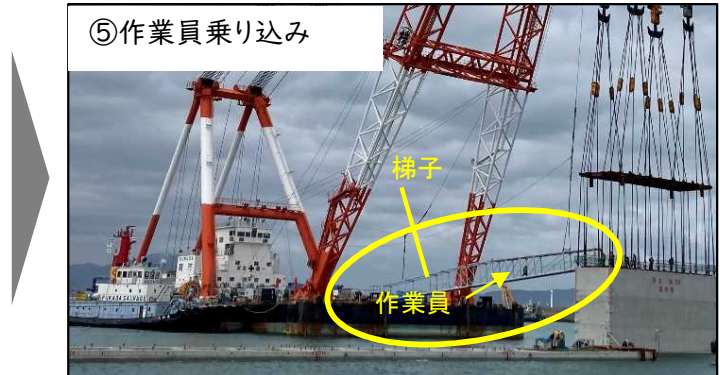
⑤作業員乗り込み ケーソンを沈める作業を行うため、起重機船から梯子を架けて、ケーソン上に作業員が乗り込みます。
