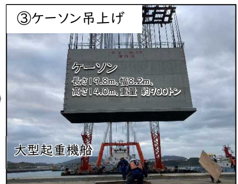
③ケーソン吊上げ 大型起重機船にて、ケーソンを吊り上げます。
