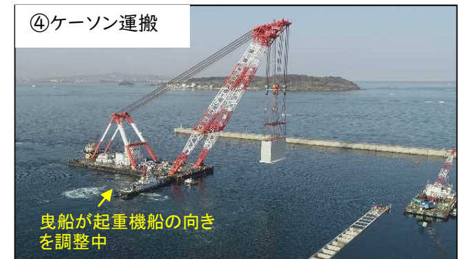
④ケーソン運搬 曳船が起重機船の向きを調整中 吊り上げたケーソンはそのままの状態、曳船により起重機船ごと据付箇所まで曳航します。
