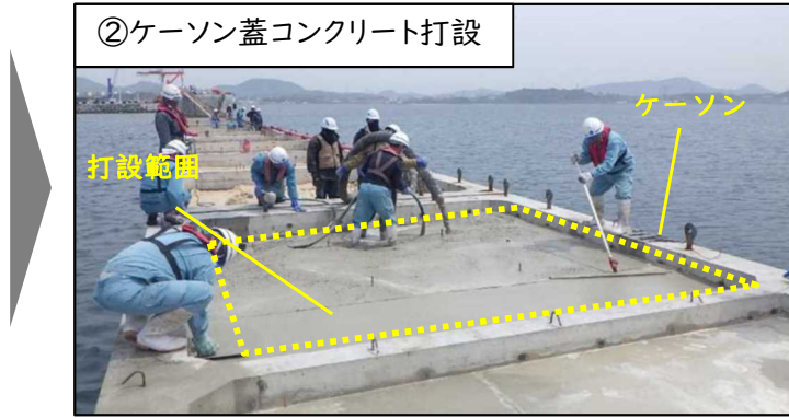
②ケーソン蓋コンクリート打設 中詰材を人力で平らに均し、コンクリートポンプ車にて圧送したコンクリートを打設し、蓋(厚さ:20cm)をします。
