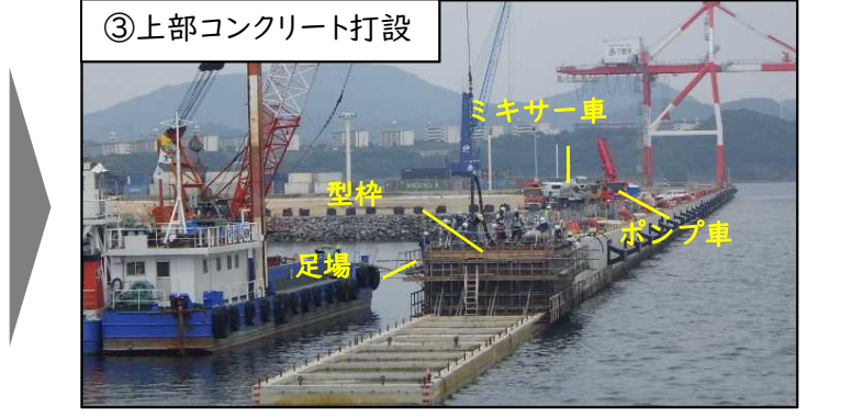
③上部コンクリート打設 ケーソン周辺に足場(人が作業できる通路)と型枠(所定の形状にコンクリートを打ち込む枠組み)を設置し、コンクリートポンプ車にて圧送したコンクリートを打設します。
