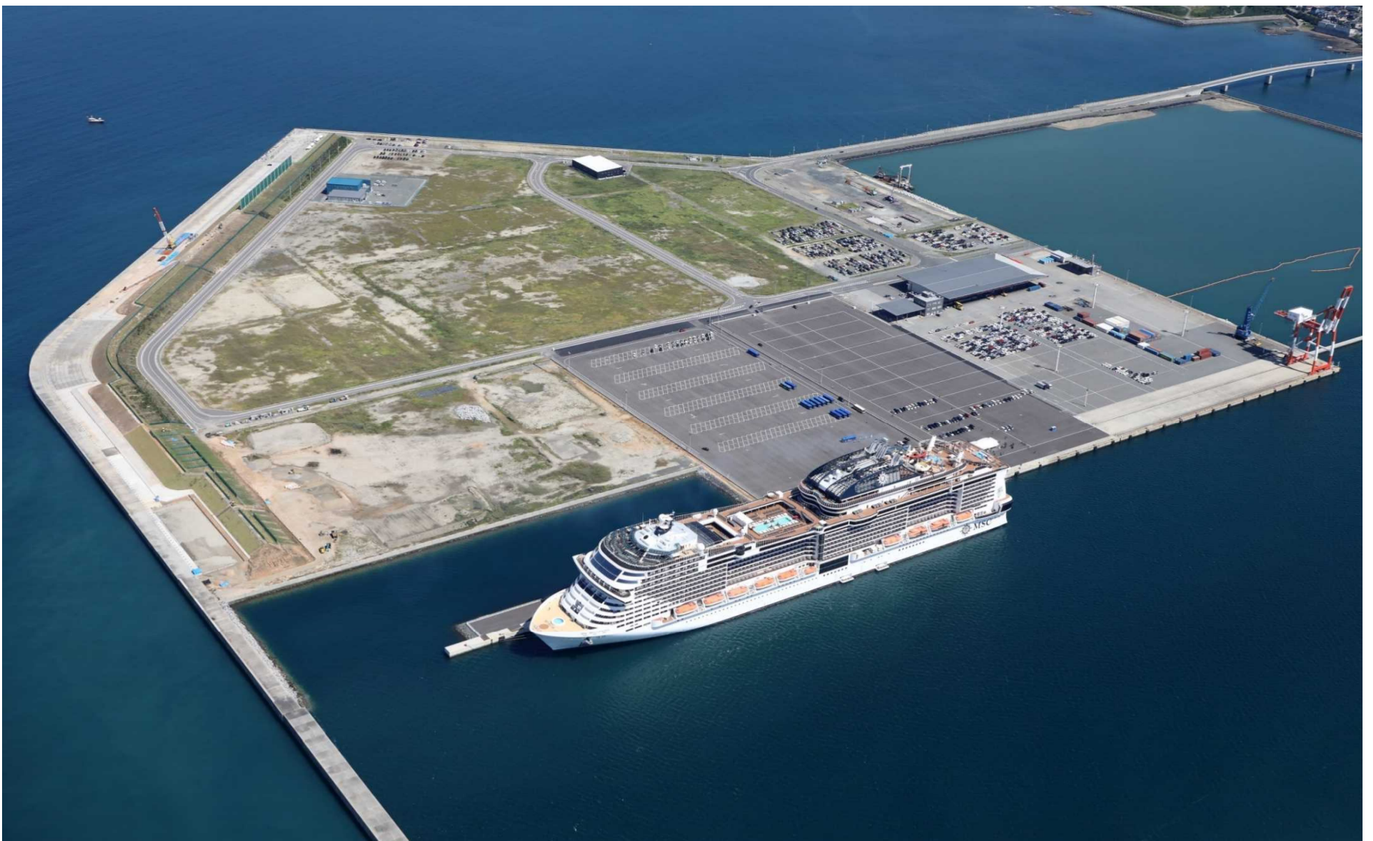
山口県内過去最大の国際クルーズ客船寄港（新港地区）
