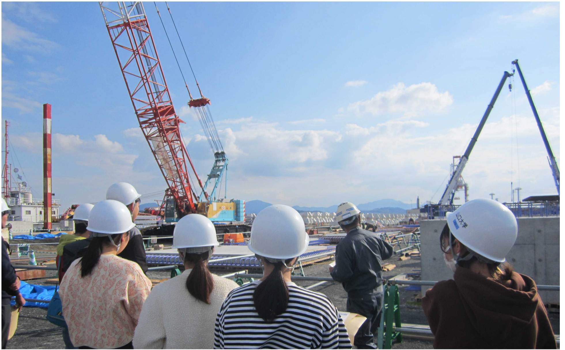
現場見学会を通じた未来の若手技術者支援（新港地区）
