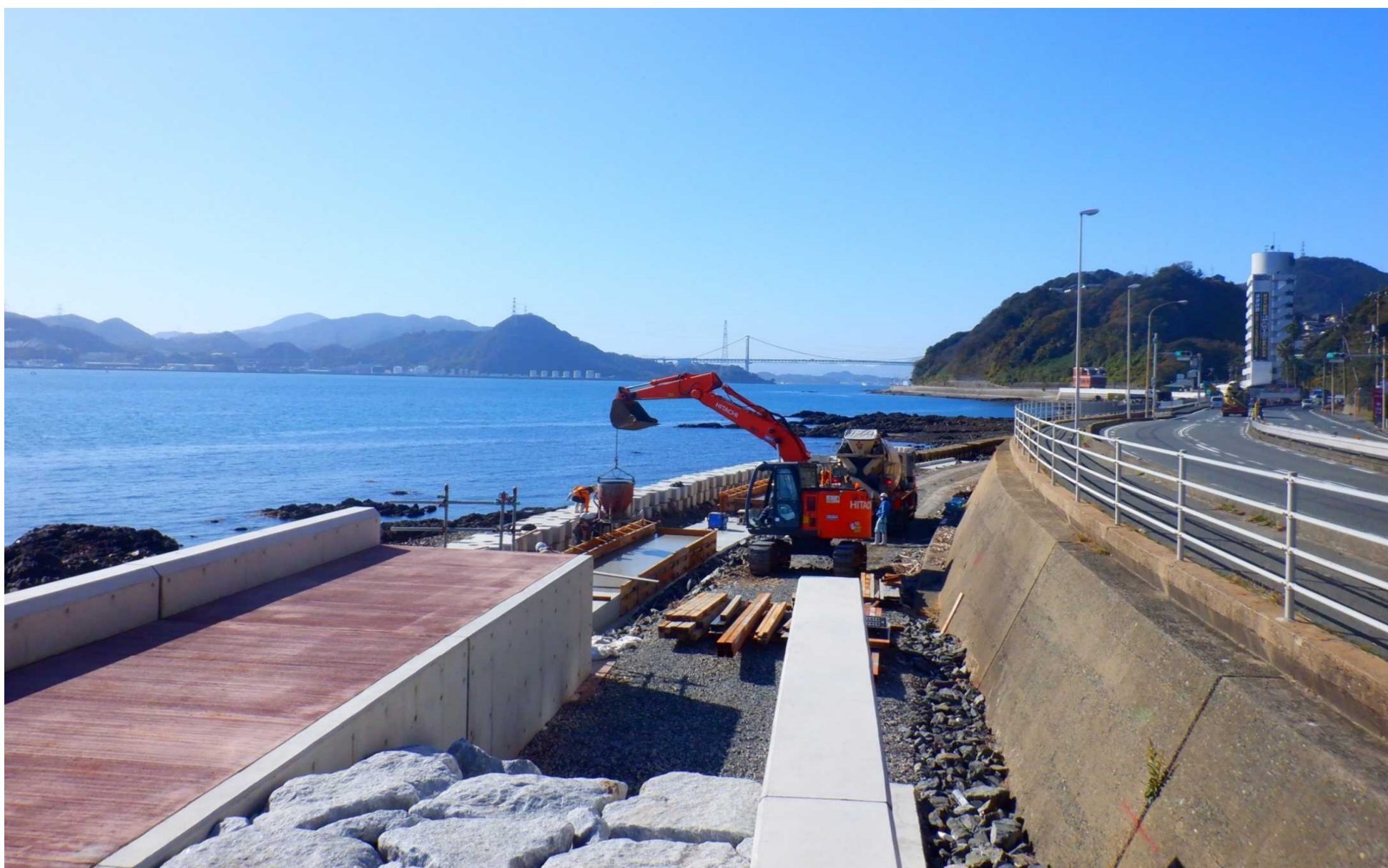
進捗する護岸工事（下関港海岸 黒門地区）
