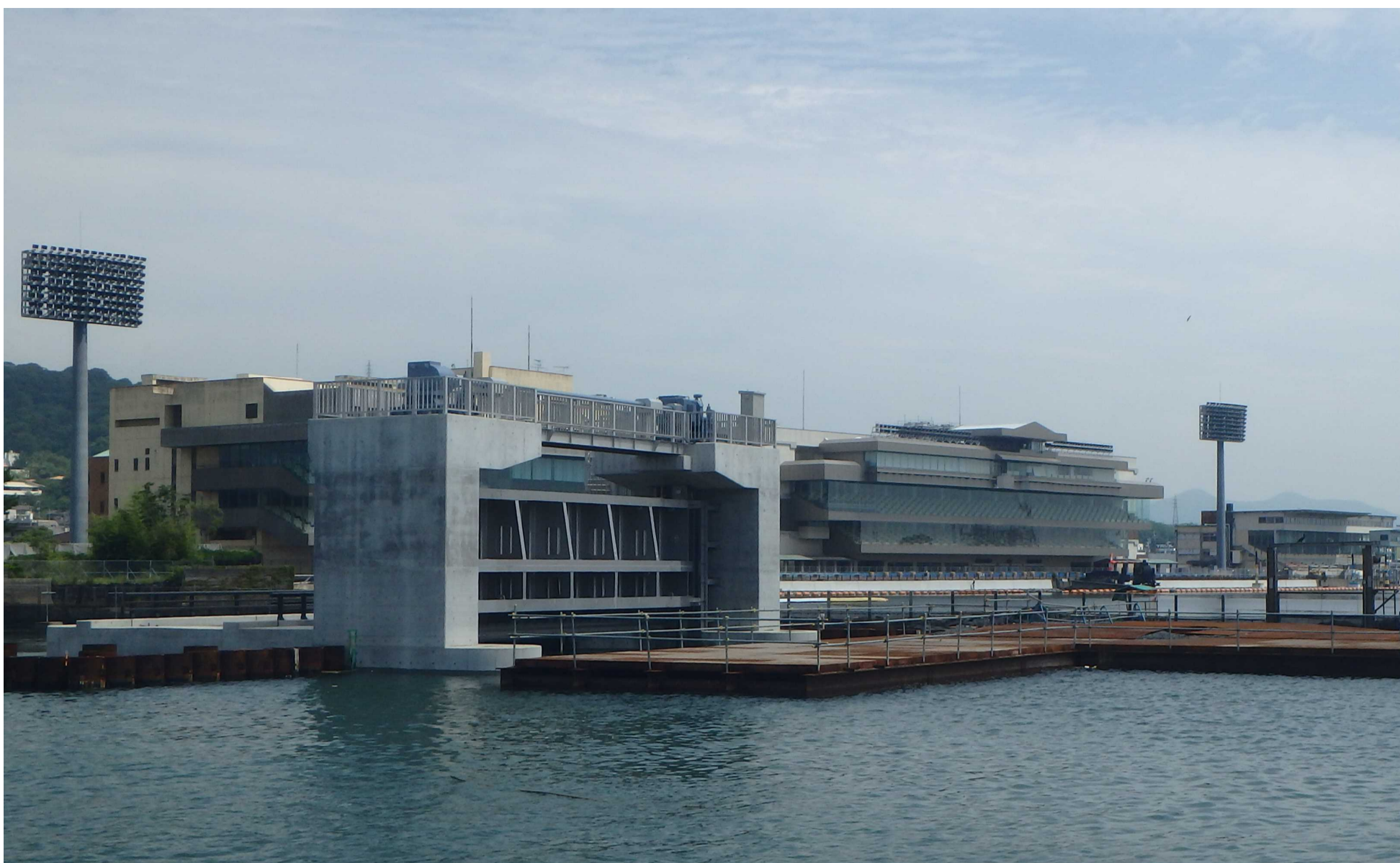
水門本体完成（下関港海岸 新川水門）
