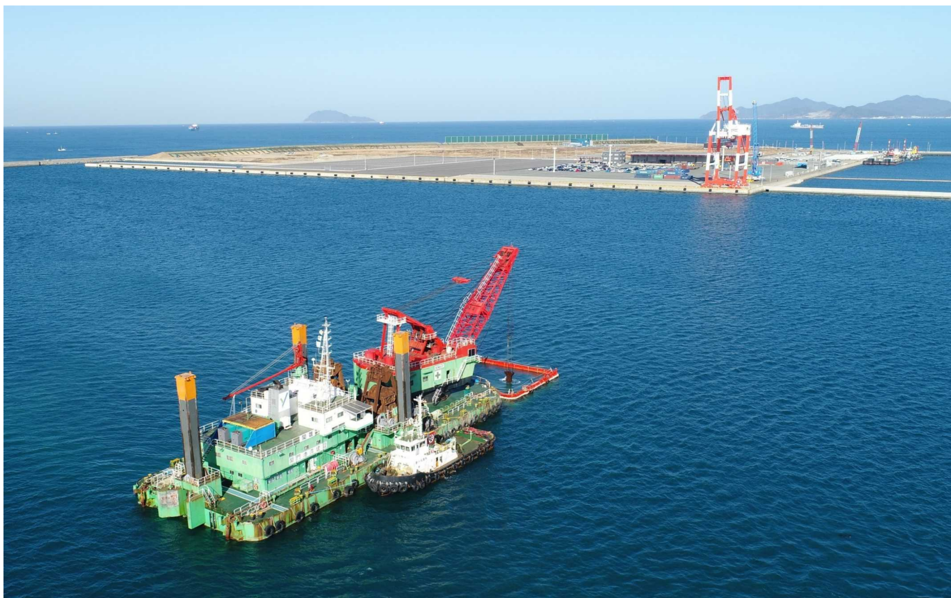
浚渫船による砕岩作業（新港地区）
