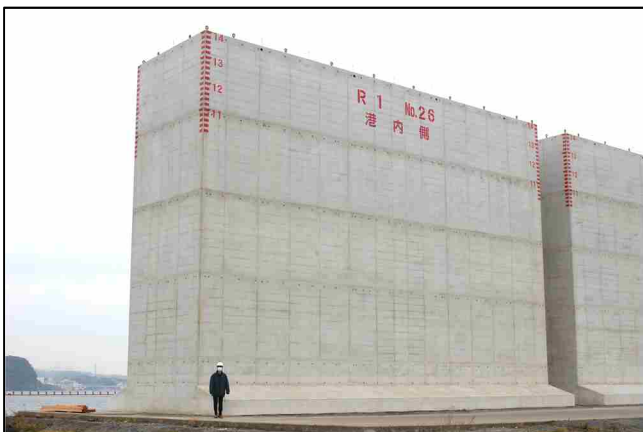
【ケーソン完成写真】
