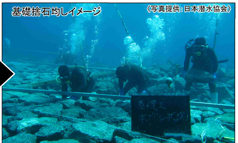
▲凹凸を平らにします。潜水土により人力作業で行います。
