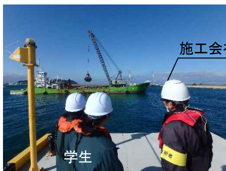
【クルーズ拠点の岸壁工事を見学】
