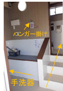
【快適トイレ内装】
