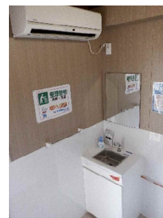
【手洗器、鏡、エアコン設置】
