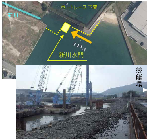
【工事の状況（鋼管矢板打設）】
