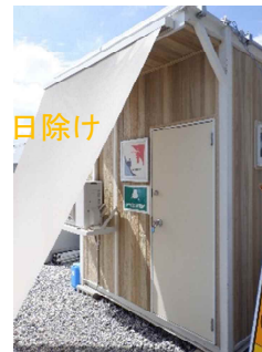
【快適トイレ外観】
