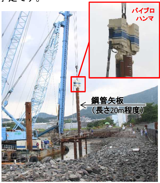
鋼管矢板打設状況(7月20日)
