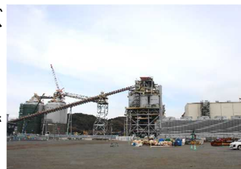
建設中のバイオマス発電所
