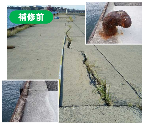
エプロン（ひび割れ、空洞化）
