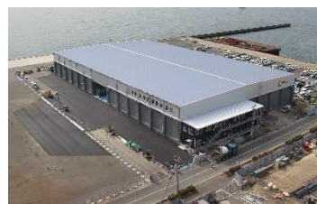
稼働予定の燃料倉庫
