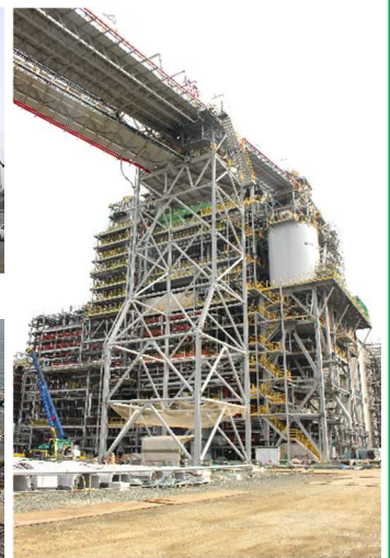
建設中のボイラー
