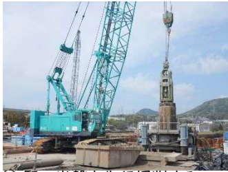
① 堅い岩盤を先行掘削する
