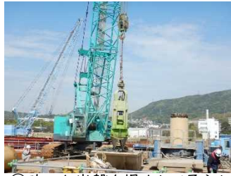
② 砕いた岩盤を揚土して柔らかい土砂に置き換える
