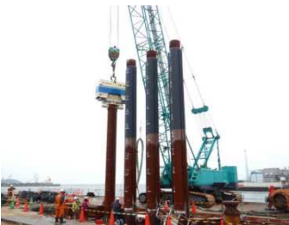
③ バイブロハンマで所定深さまで鋼管矢板を押し込む
