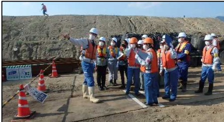
現場にて工事の説明
