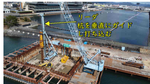
鋼管杭打設状況
