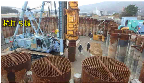
鋼管杭打設状況
