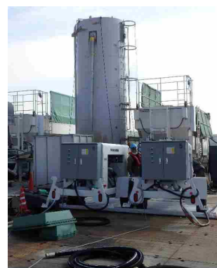
プラント設置状況
