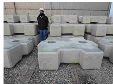
コンクリートが固くなったら被覆ブロック完成!
