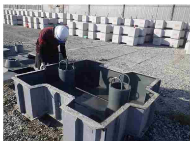
所定の形状となるように鋼製の型枠(枠組み)を組み立てます。
