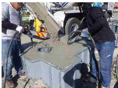
型枠内にコンクリートを流し込みます。
