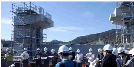
新川水門工事の現場見学
