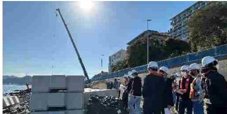
護岸工事（黒門地区）の現場見学
