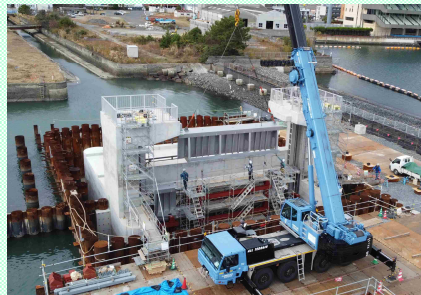
ゲート取付け状況
