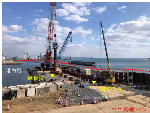
宮崎水門（防波堤工区）鋼管杭打設状況
