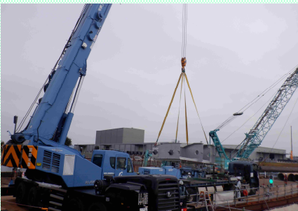
ゲート搬入状況
