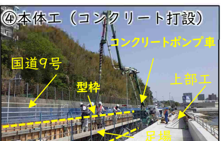
④本体工 (コンクリート打設) 上部工と同様にコンクリートポンプ車にてコンクリートを流し込みます。
