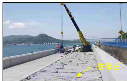
被覆石投入後の状況
