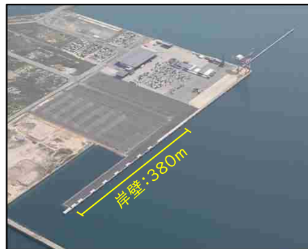
完成写真 (R5.5.17撮影)
