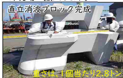
直立消波ブロック完成 重さは、1個当たり2.8トン コンクリートが固くなったなら型枠を外してヤード内に仮置きします。
