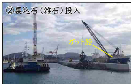
ガット船を使用し、ケーソンの背後に雑石(5~100kg/個程度)を投入します。
