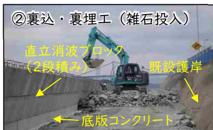
②裏込・裏埋工 (雑石投入) 上部工、被覆工、本体工 (場所打ちコンクリート壁) を施工する高さまで雑石 (5~100kg/個程度) を投入します。
