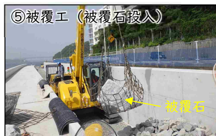
⑤被覆工 (被覆石投入) 上部工と本体工の間にバックホウ等を使用して被覆石 (1トン/個程度) を敷き詰めます。
