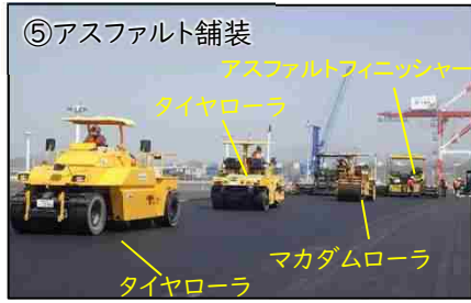
舗装材をアスファルトフィニッシャーにて敷均し、タイヤローラ、振動ローラにて締固めます。
