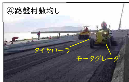
強固な道路を作るため、路盤材をモータグレーダで均等に敷均し、タイヤローラ、マカダムローラーにて締固めます。
