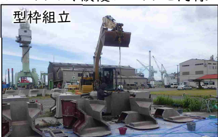
型枠組立 所定の形状となるように型枠を組み立てます。
