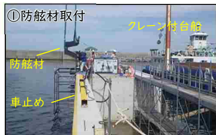
船舶が係船するために必要な防舷材を取付けます。
