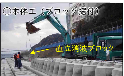
①本体工 (ブロック据付) トラックにて、運んできた直立消波ブロックをバックホウで吊り上げ据付けます。
