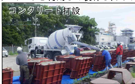
コンクリート打設 型枠内にコンクリートを流し込みます。
