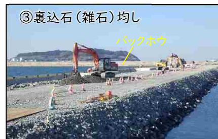
雑石投入後、バックホウを使用して表面を平らに均します。
