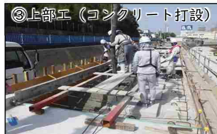
③上部工 (コンクリート打設) 型枠内 (上部工施工箇所) にコンクリートポンプ車にてコンクリートを流し込みます。
