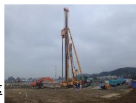
岸壁の地盤改良工事の様子
