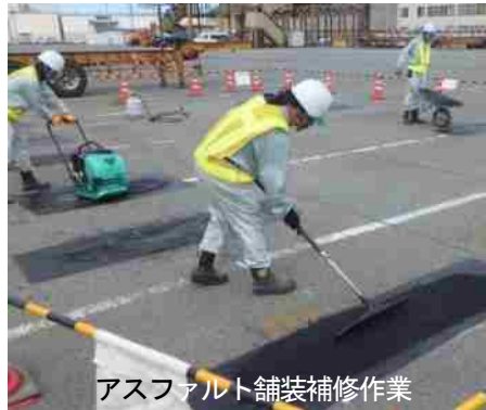
加熱アスファルト流し込み作業
