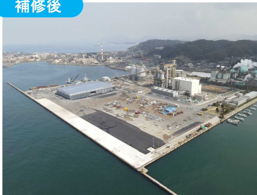
エプロン(地盤改良、コンクリート舗装)
