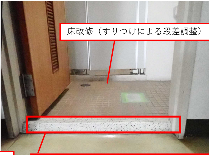
床改修 （赤枠部撤去及び扉の増設による段差調整）
