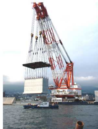
防波堤工事の様子
