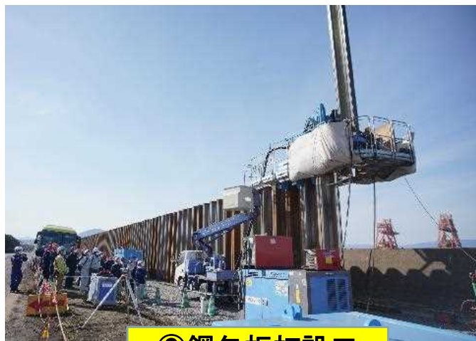
②鋼矢板打設工
