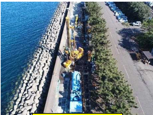
①地盤改良工
