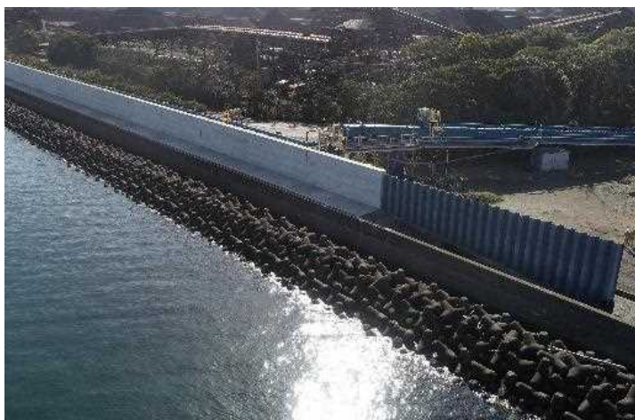
◎整備状況(遠景)
