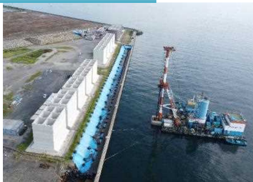
①地盤改良工
