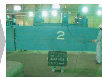
⑥事前に測量した位置へ造波機を設置する。（振動防止用のカウンターウエイトを乗せる）
