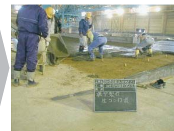
③中詰土の表面にコンクリートを打設する。
