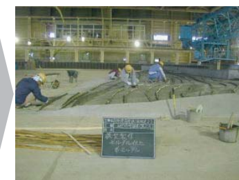
④等深線の間隔をモルタルで仕上げる。
