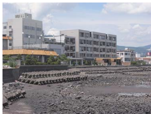
護岸前面に積まれた消波ブロックが干潮時に露出する宿泊施設等の前面海岸
