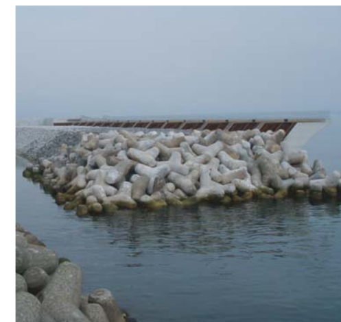
施工中の護岸（平成23年3月）
