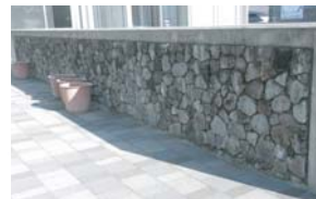
施工事例(べっぴアリーナ)
