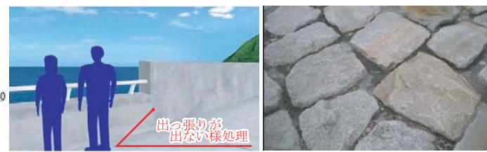
変更案 (写真②)被覆石の施工事例
