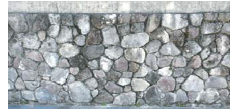
別府石による壁面処理の事例（べっぶアリーナ）
