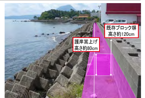
護岸嵩上げイメージ (東京靴流通センター前) 東京靴流通センター前の護岸は、護岸上に高さ約120cmのブロック塀がある。東京靴流通センターの必要護岸嵩上げ高さは、約80cmのため、既存のブロック塀よりも低い。護岸背後から海側を眺めたとき、既存のブロック塀よりも護岸が高くないことから、海への眺めは変わらない。
