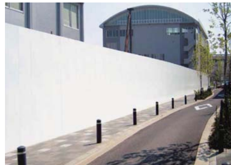
仮囲い例 ※陸上工事中
