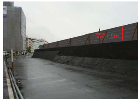
防波板(仮設防護柵)※海上工事中
