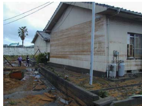
1999年の台風18号通過後の熊本県不知火町松合地区の状況。家屋の壁には、屋根近くまで高潮が到達したことを示す痕跡（付着物が、実際の水位を示している）が見られる。
