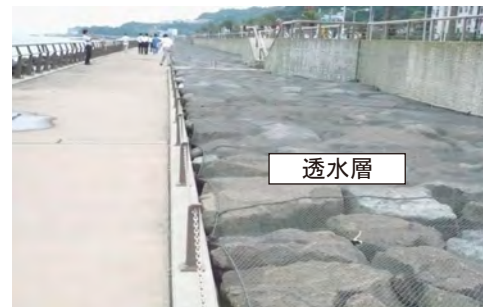
透水層を用いた二重パラペット型護岸の事例 (馬堀海岸：神奈川県)
