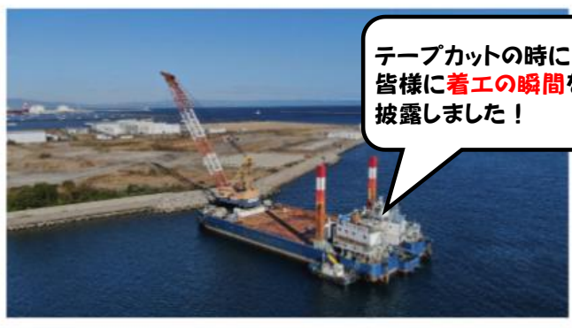
工事着工状況(消波ブロックを撤去している状況)
