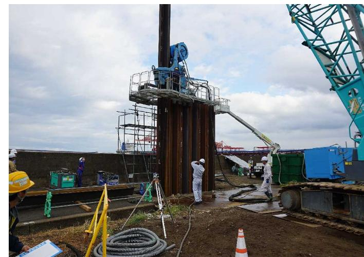
**■バイブロ工法** バイブロハンマにより鉛直方向の振動を発生させ、この振動を鋼矢板に伝え土中に打ち込む工法です。打撃力を用いないため、矢板頭部の損傷もなく施工能率が高いうえ、打ち込みだけでなく引き抜きにも利用できます。
