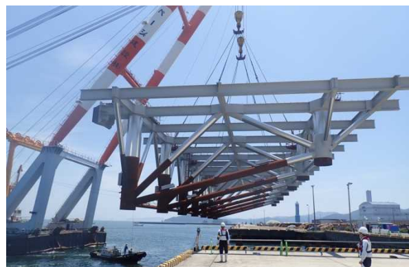
—H30.7.14(土)に実施した岸壁改良工事の施工状況(ジャケット据付)—
