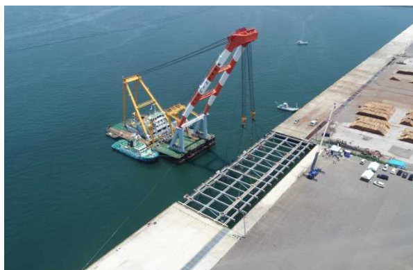
—H30.7.14(土)に実施した岸壁改良工事の施工状況(ジャケット据付)—
